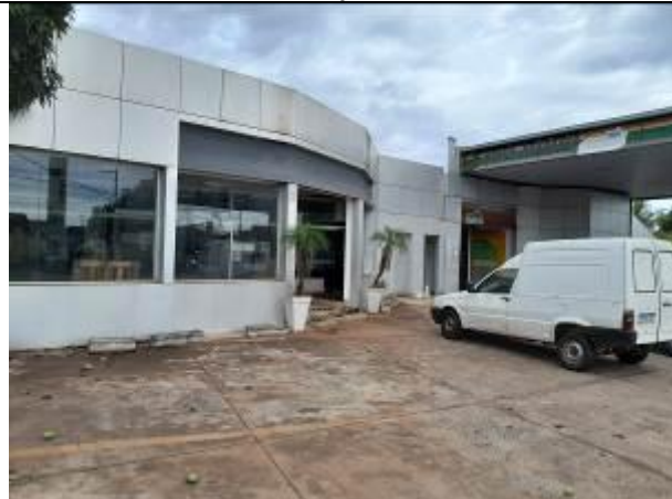
Vista Parcial da Loja de Conveniência, Troca de Óleo e Escritório
