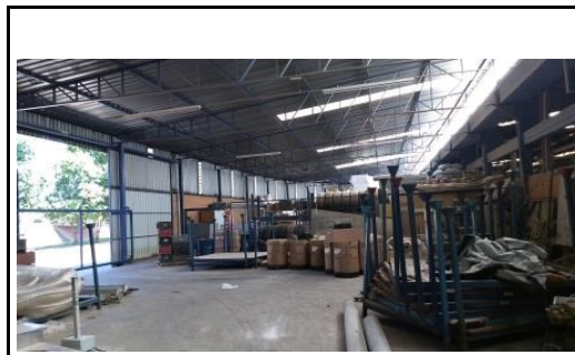
Vista do Galpão
