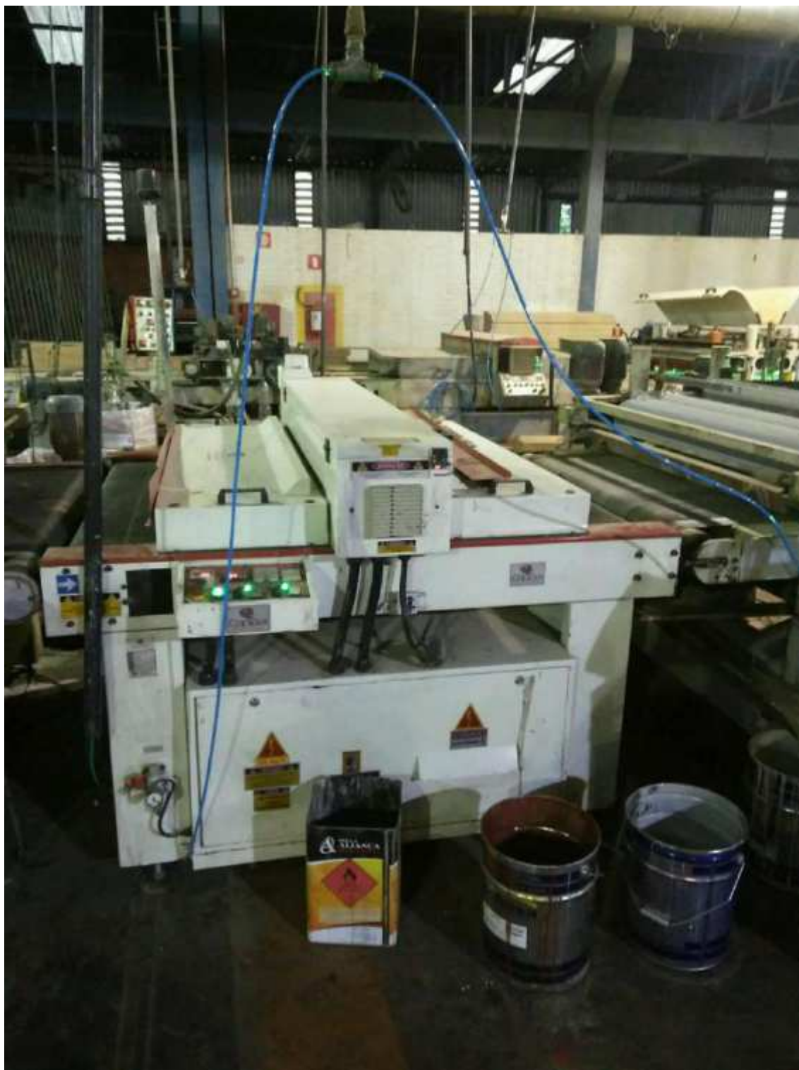
Fig. 219: Túnel UV 1 Lâmpada
