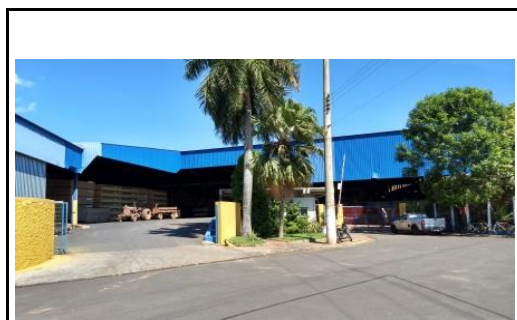
Vista do Galpão
