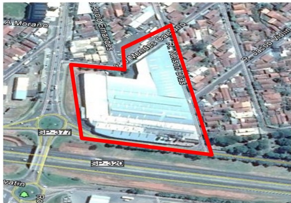
Vista Aproximada da Implantação do imóvel
