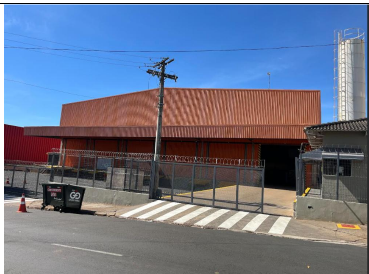
Vista externa do galpão localizado a Rua José Guidi – Distrito Industrial Waldemar Oliveira Verdi estando locado a empresa VR Painéis.
