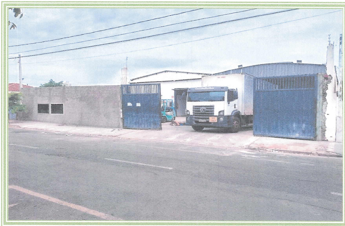
FACHADA DO IMÓVEL = R. PROF. FRANCISCO PURITA, 342
