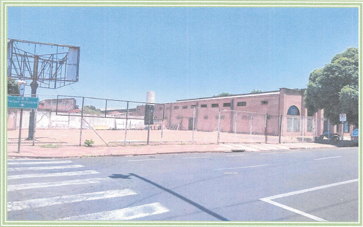
VISTA EM DIAGONAL DO IMÓVEL E ESTACIONAMENTO
