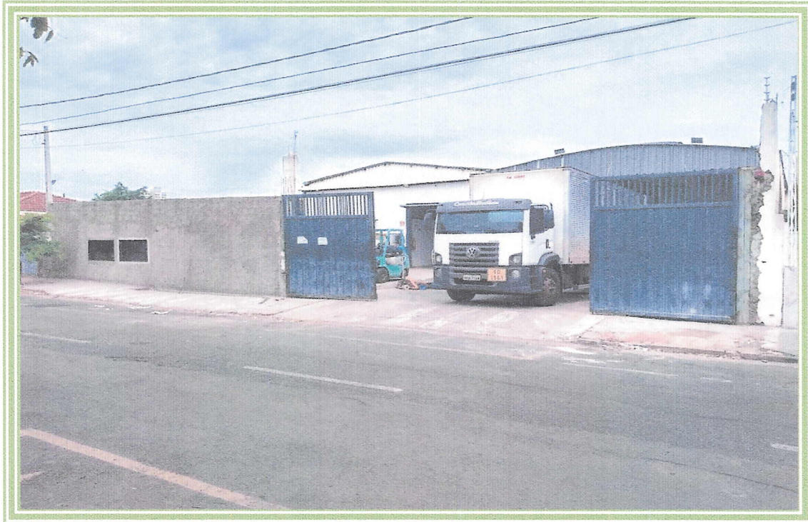
FACHADA DO IMÓVEL = R. PROF. FRANCISCO PURITA, 342
