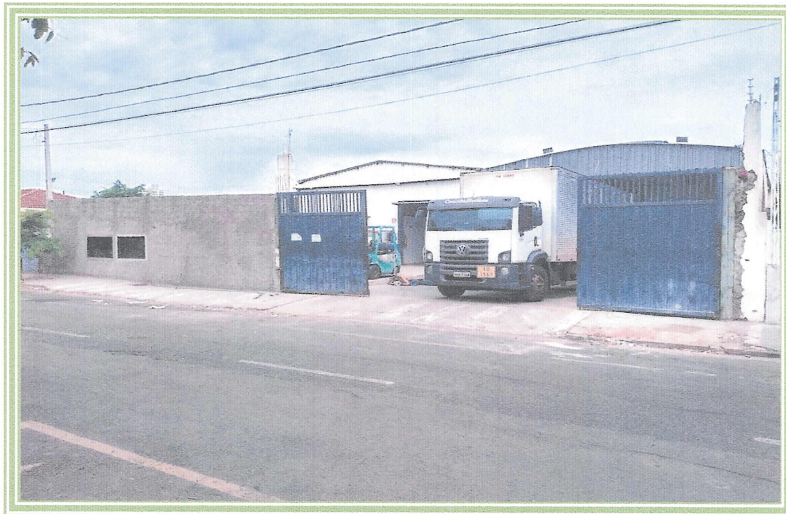
FACHADA DO IMÓVEL = R. PROF. FRANCISCO PURITA, 342
